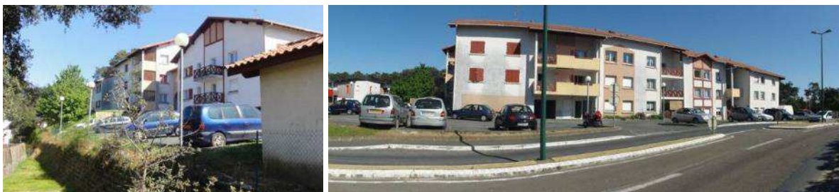
Immeubles d'habitat collectif avec parkings peu valorisants et absence d'espaces verts
