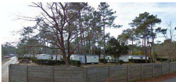
Camping partiellement intégré en raison des bardages clairs des mobile homes et des haies de thuyas peu en lien avec la végétation locale.
