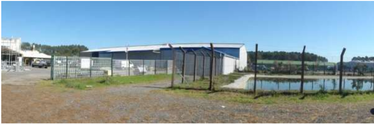
Traitement peu soigné des clôtures et des abords
