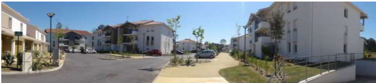
Logements collectifs cherchant à s'intégrer avec l'habitat traditionnel et de style d'influence basco-landais sur le bourg de Labenne – Espaces verts qualitatifs (Cf. § ci-après)
