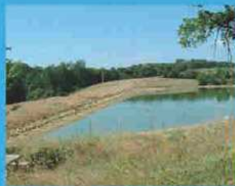
Barrage de Arthez (© DDTM40 - SPE)
