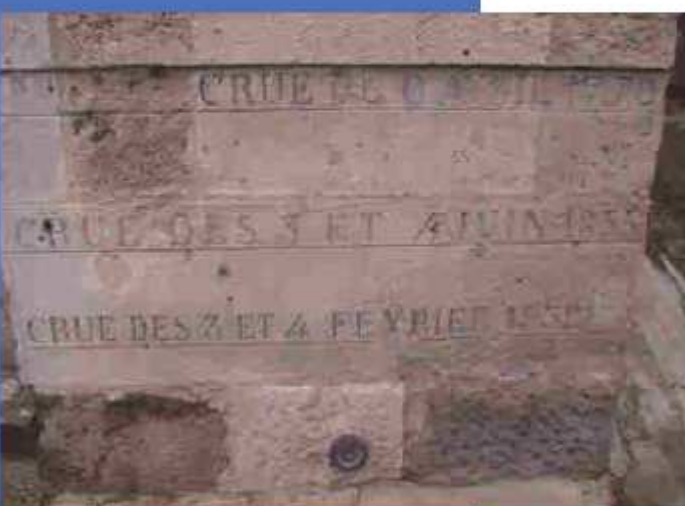
Exemple de repères de crues sur l'église de Grenade-sur-Adour (©DDTM 40).
