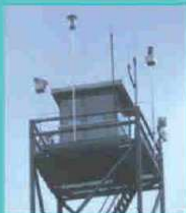
Tour de guet équipée du système PRODALIS (© SDIS 40)
