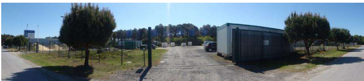
Absence de liaison douce, accotements peu entretenus, aires de stockage et clôtures peu valorisantes...
