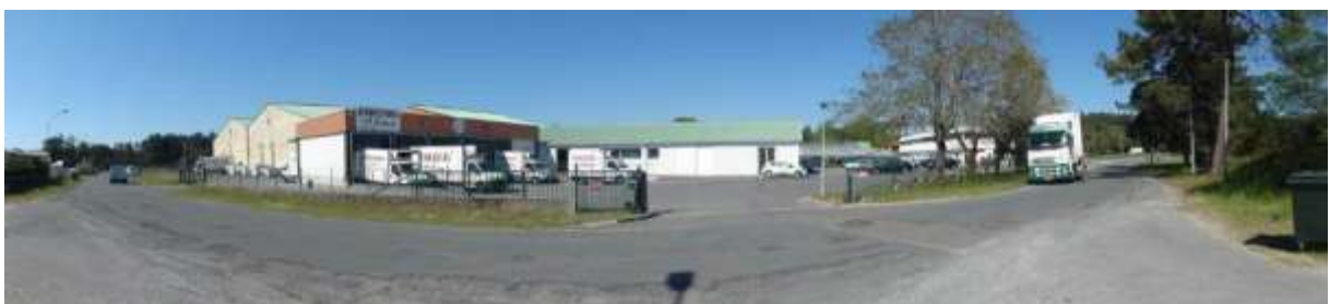
Clôtures grillagées laissant entrevoir les aires de manœuvre, de stationnement de stockage...
