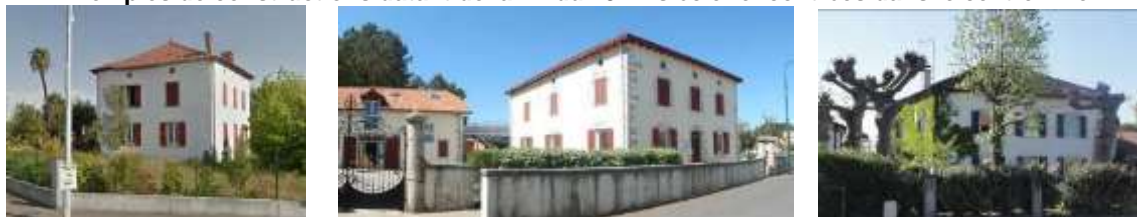
Exemples de maisons de maître de la fin du 19 ème siècle et du début du 20 ème siècle
