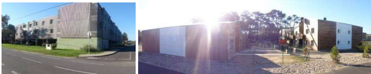
Logements collectifs d'architectures contemporaines sur Labenne-Océan
