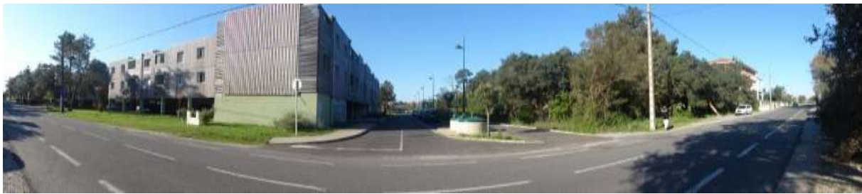
Caractère très routier de la traversée à Labenne-Océan
