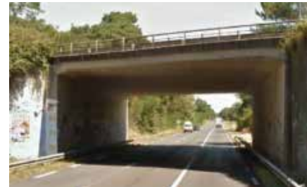
Pont de la route D 810 avant travaux.
