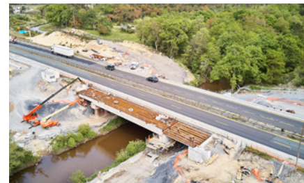
Ouvrage de franchissement du Boudigau
